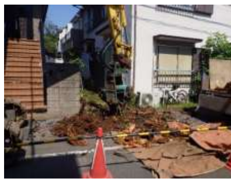
図 11 圧砕機による抜根作業
