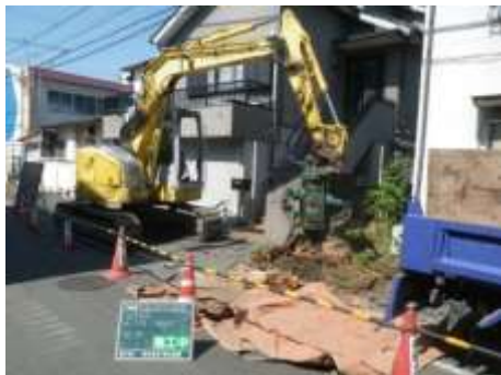
図 5 撤去状況(住宅脇)
