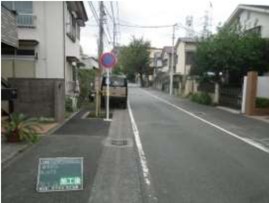
図 12 施工後(住宅脇)
