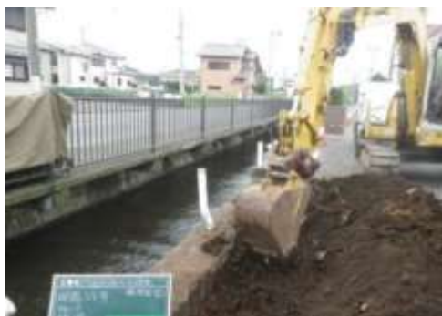
図 9 抜根状況(仕上げ)(水路)
