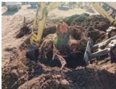
図 10 バケットによる抜根作業
