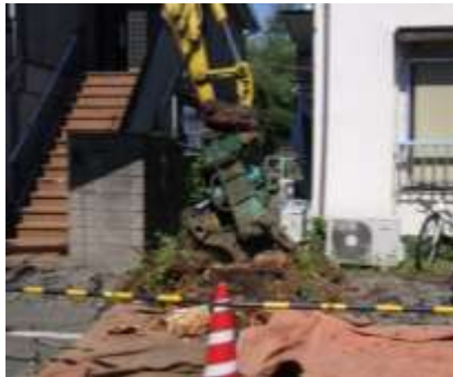
図 6 撤去状況(住宅脇)
