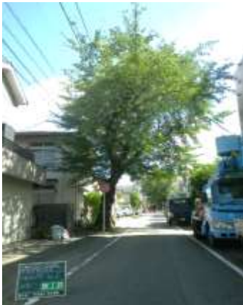
図1 施工前(住宅脇 街路樹)
