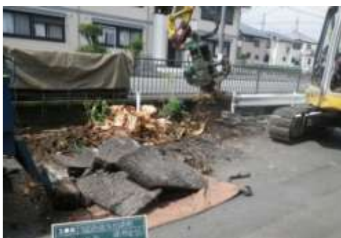
図 8 抜根状況(水路)
